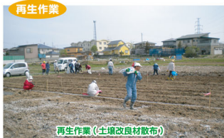
再生作業（土壌改良材散布）
